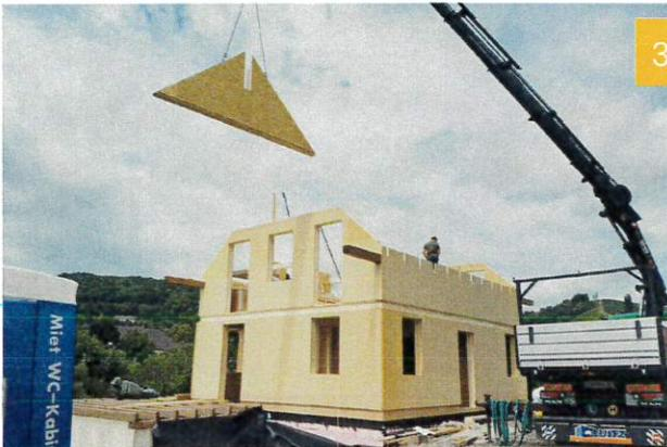
3 Fertigwände werden versetzt
