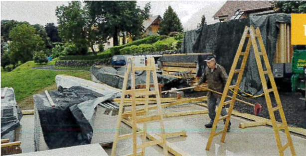
1 Betonplatte mit montierter Fußschwelle
